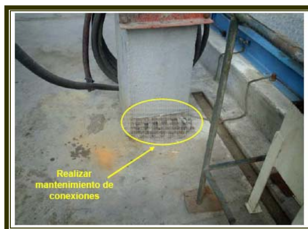
Figura 2.18 Mantenimiento de conexiones
