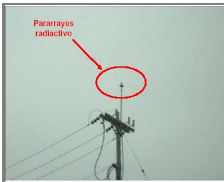
Figura 2.32 Pararrayos radioactivos.
