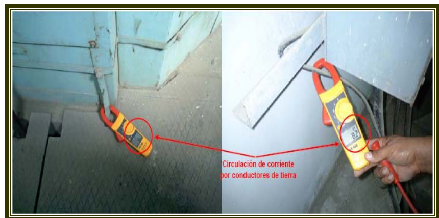
Figura 2.16 Circulación de corrientes por conductores a tierra
