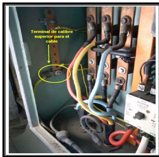
Figura 2.14 Terminal de calibre superior para el cable.
