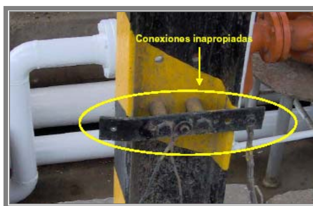
Figura 2.39 Conexiones inapropiadas
