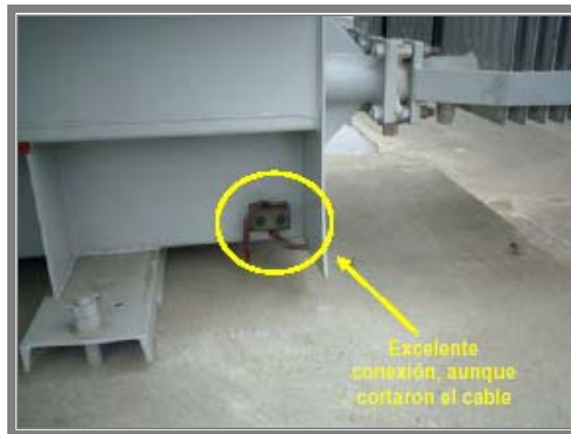
Figura 2.36 Conector adecuado
