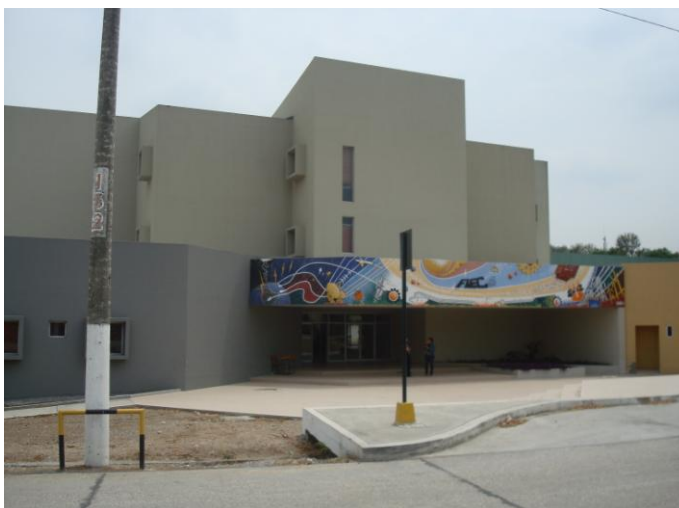
Figura 4-14 Edificio Central de la FIEC
