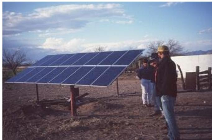
Consiste en la **conversión** directa de la luz solar en electricidad, mediante un dispositivo electrónico denominado "célula solar"; estas células se interconectan y agrupan en módulos que pueden generar 0,9Kwh/día  $m^2$  (aprox.  $1,5m^2$  un módulo).
