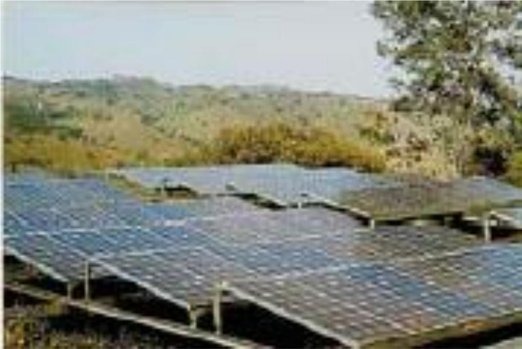
La transformación directa de la energía solar en energía eléctrica se realiza en un equipo llamado módulo o panel fotovoltaico. Los *módulos o paneles solares* son placas rectangulares formadas por un conjunto de *celdas fotovoltaicas* protegidas por un marco de vidrio y aluminio anodizado.
