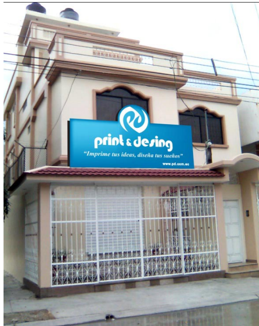
Figura 48 (3.48) Muestra de infraestructura
