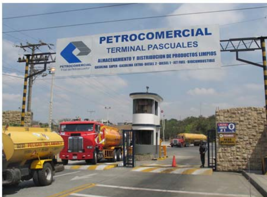
Figura 3-5: Terminal de Pascuales de Petrocomercial.
