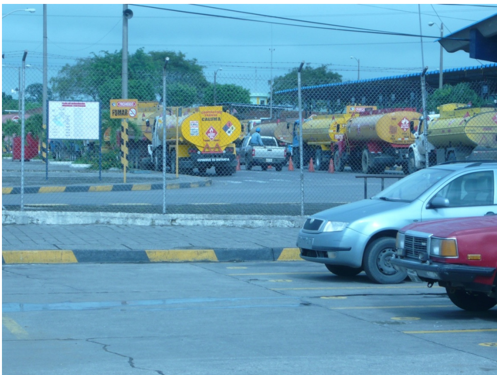
Figura 1-3. Área de despacho de combustible terminal Pascuales Petrocomercial
