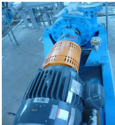
Figura 4-27. Bomba centrífuga horizontal
