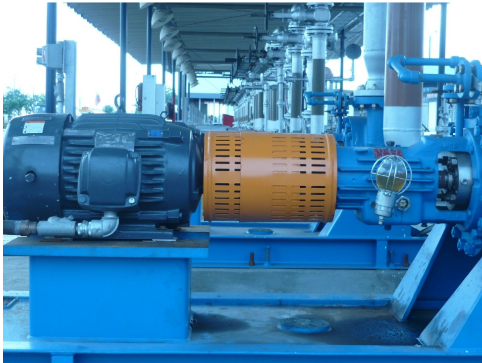
Figura 2-2. Motor y bomba acoplada a un eje
