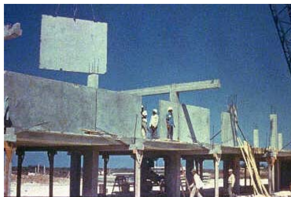
Fig. 1. Montaje de un Edificio Prefabricado
