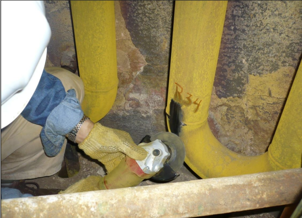
Figura 2.3 DESBASTE GRUESO CON LA AMOLADORA
