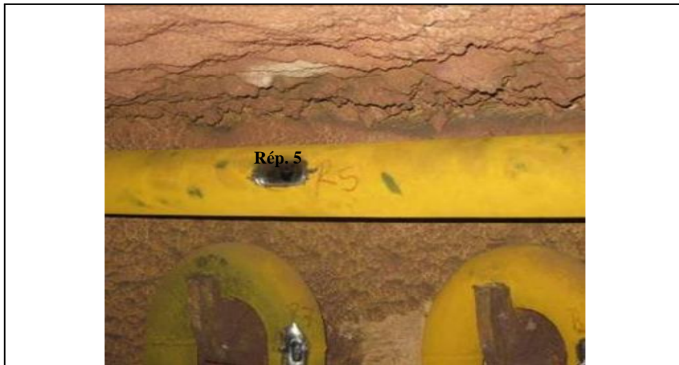
Fig. 20 Ubicación en zona convectiva-Techo. Tubo de Unión Paso 2 y 3.
