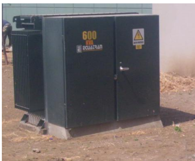
Figura 8. Vista exterior de transformador trifásico tipo Padmounted.
