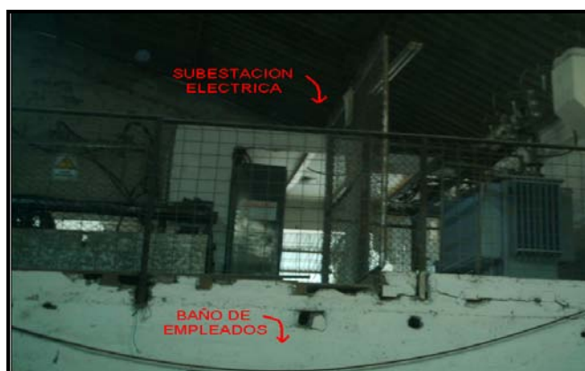
FIGURA 5.1 Ubicación de Subestación Eléctrica.
