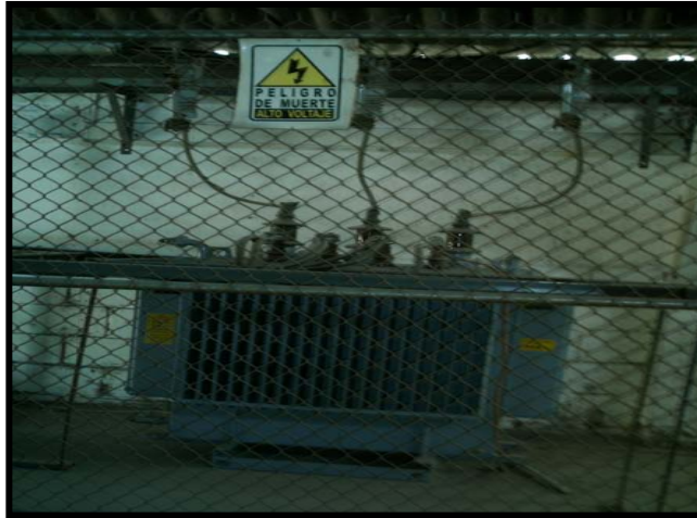
FIGURA 5.2 Espacio de seguridad de transformador de 300KVA
