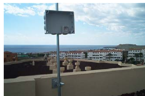
Figura 6.1-2 Instalación Caja Estanca
