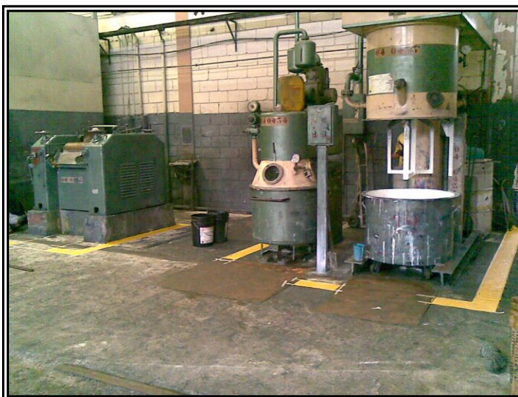
FIGURA 4.9. LINEAS ÁREA DE EQUIPOS
