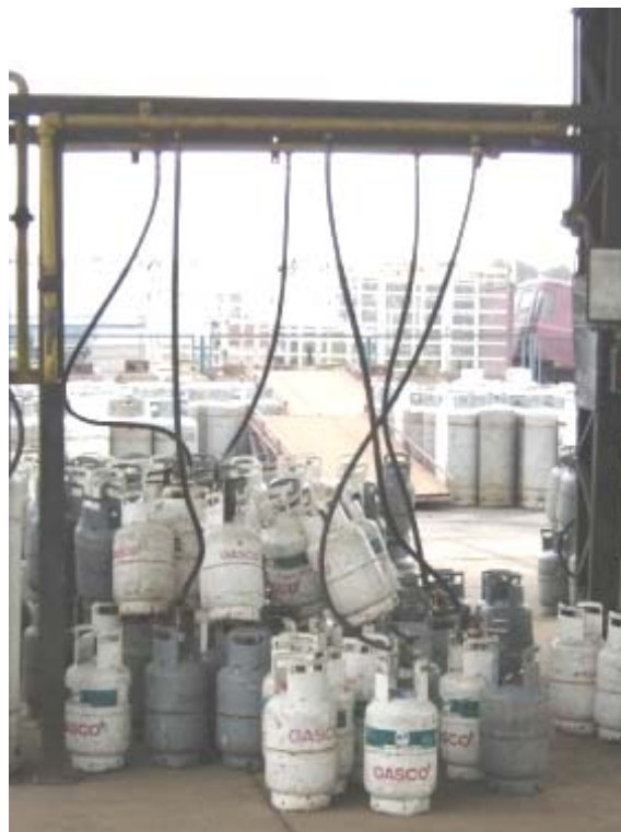
FIGURA 2.2 EXTRACCIÓN DE GLP VAPOR EN SISTEMA NO. 2.
