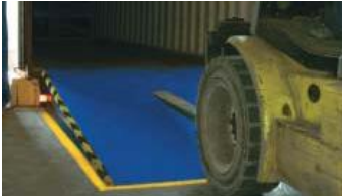
FIGURA 5.5. FOTO DE RAMPA DE ALTURA VARIABLE
