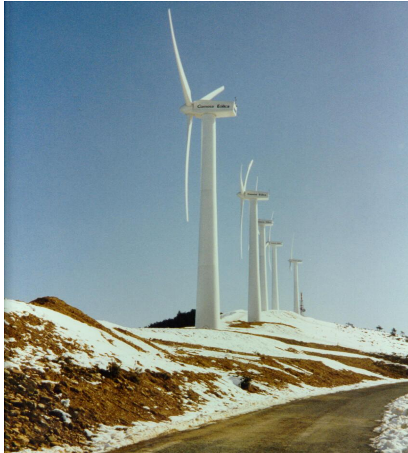
Figura 1.4: Campo de Generadores Eólicos
