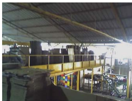
FIGURA 2.9 PASILLO QUE UNE EL ÁREA DE ARMADO DE CAJAS CON EL ASCENSOR DE LA BODEGA DE CAJAS
