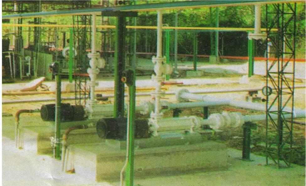
**FIGURA 1.3. BOMBAS PARA EL TRASIEGO DEL GLP**
