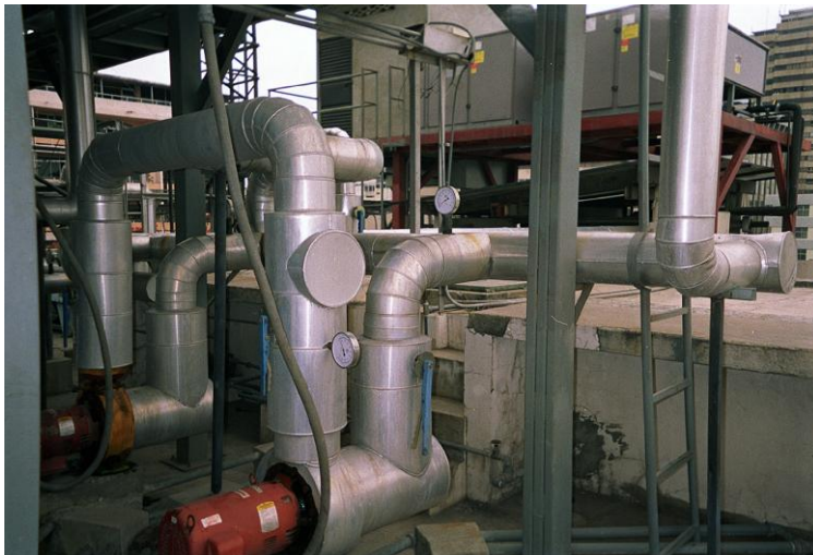
FIGURA 2.7 CIRCUITO SECUNDARIO DE BOMBAS
