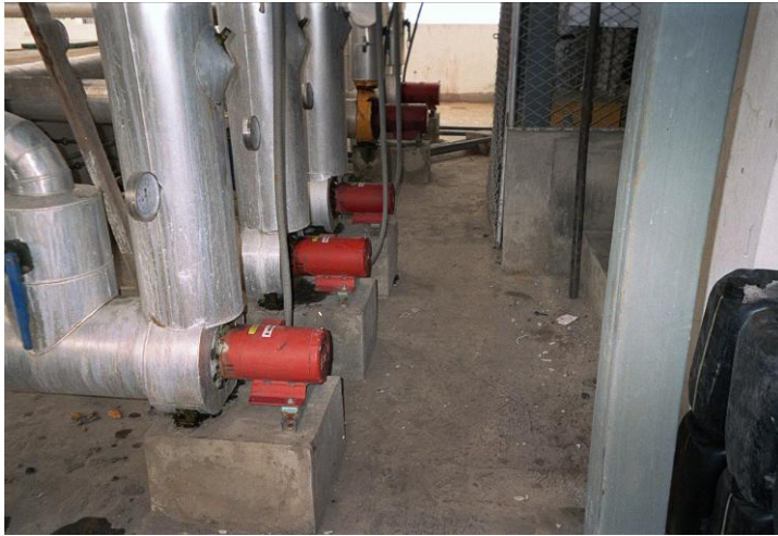
FIGURA 2.6 CIRCUITO PRIMARIO DE BOMBAS
