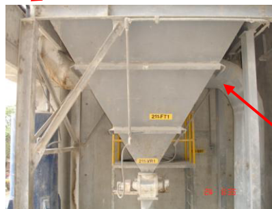
FIGURA 4.3. ENTRADA DE DUCTOS EN SENTIDO OPUESTO
