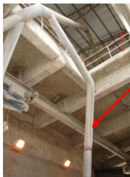
FIGURA 4.6. ENTRADA DE AIRE FALSO
