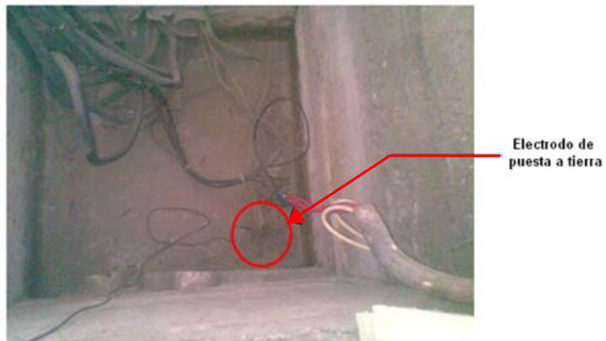
Fig. 3. 3 Ubicación del electrodo de puesta a tierra
