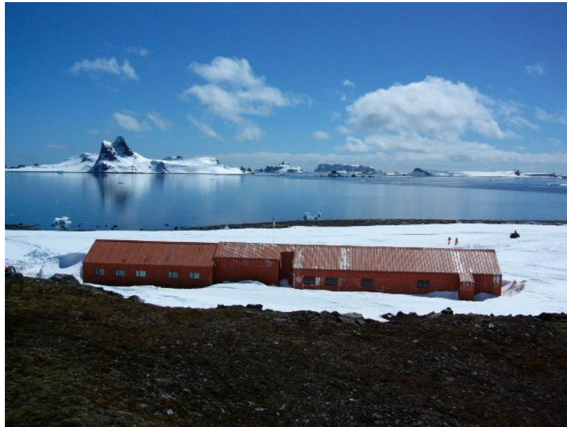
FIGURA 4.1. FOTOGRAFÍA DE LA ESTACIÓN FACHADA POSTERIOR
