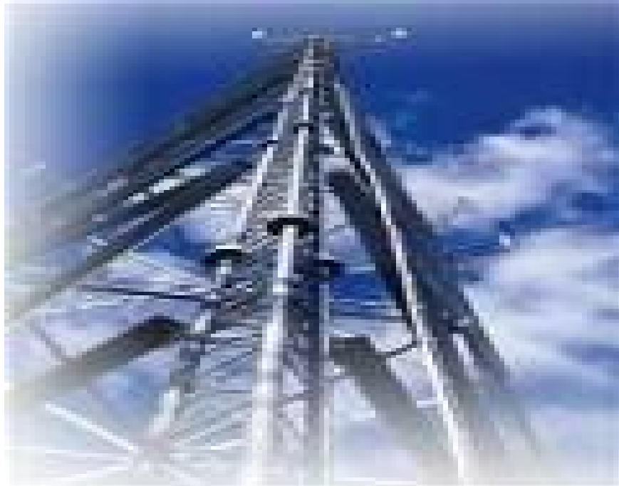
FIGURA 1.1 TORRE AUTOSOPORTADA PATA CELOSÍA
