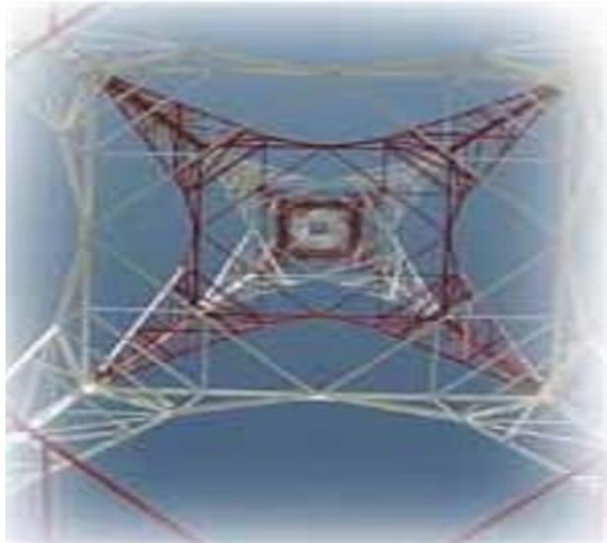
FIGURA 1.2 TORRE AUTOSOPORTADAS PATA ANGULO
