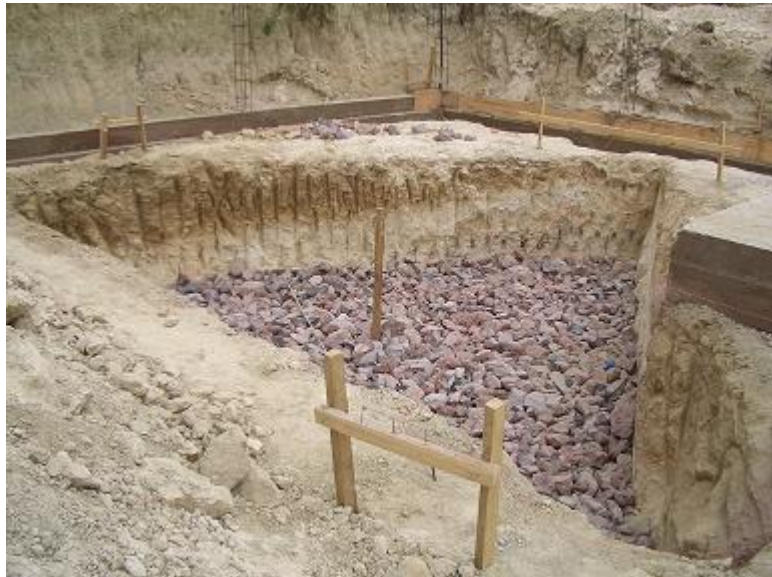
FIGURA 2.11 MEJORAMIENTO DEL SUELO
