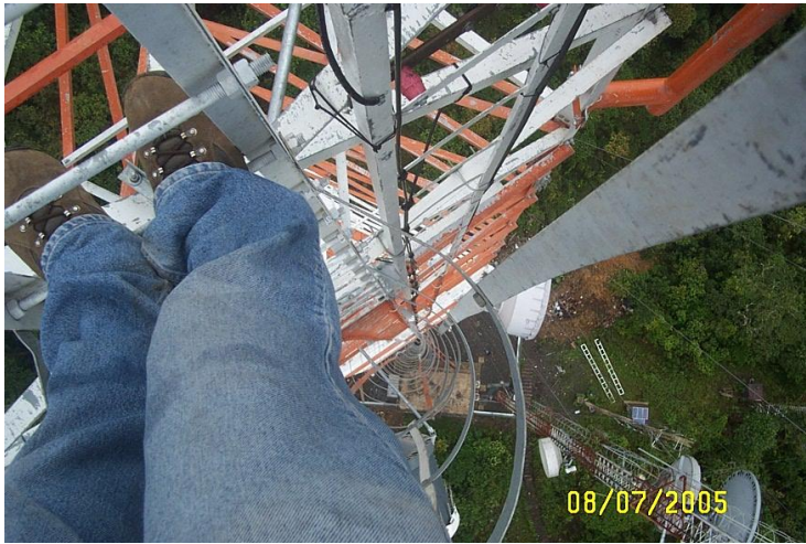
FIGURA 2.2 ANILLOS DE SEGURIDAD
