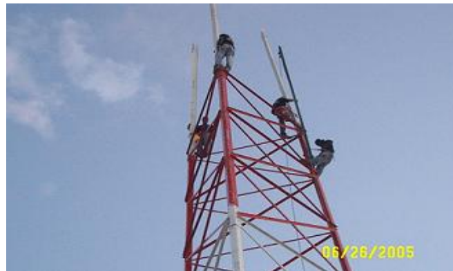
FIGURA 2.15 MONTAJE DE TORRE
