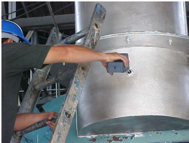
Figura 4.1. Análisis de los gases de escape de la caldera
