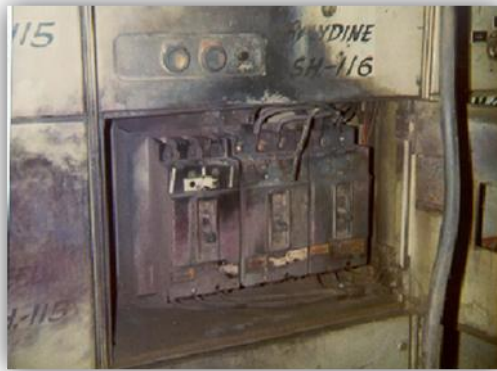
Fig. 2 Corto Circuito dentro de un TBT
