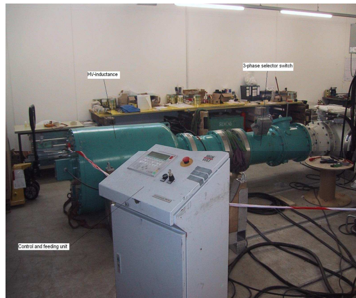
Fig 25. Equipo para prueba de Alta Tensión
