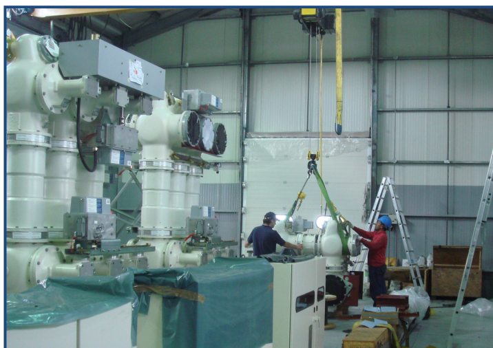
Fig 15. Proceso de montaje.
