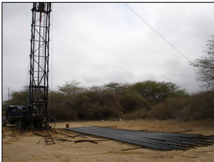
FIGURA 1.13 RETIRO DE VARILLAS Y TUBERÍA PARA PROFUNDIZAR UN POZO
