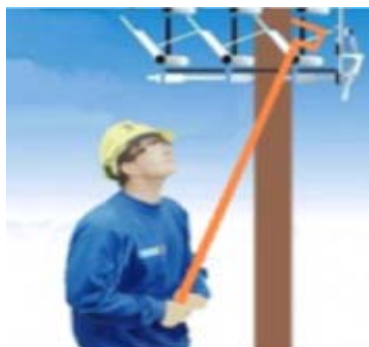
Fig. 5.1. Desconexión del circuito.
