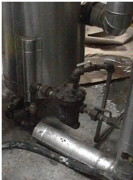
FIGURA 1.21 TANQUE FLASH DE PRECALENTADOR TRIPLE
