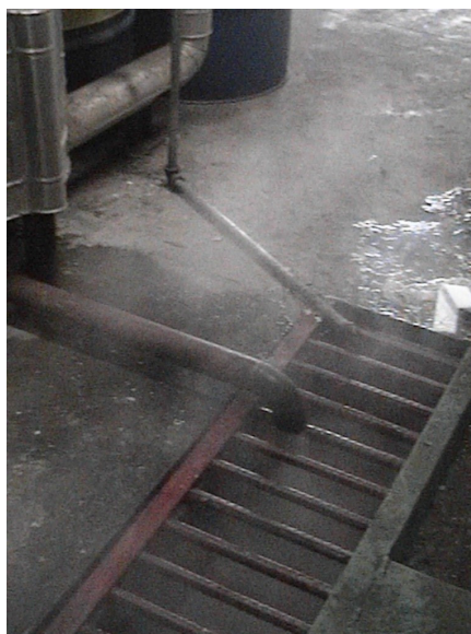
FIGURA 1.17 DESCARGA DE VAPOR Y CONDENSADO
