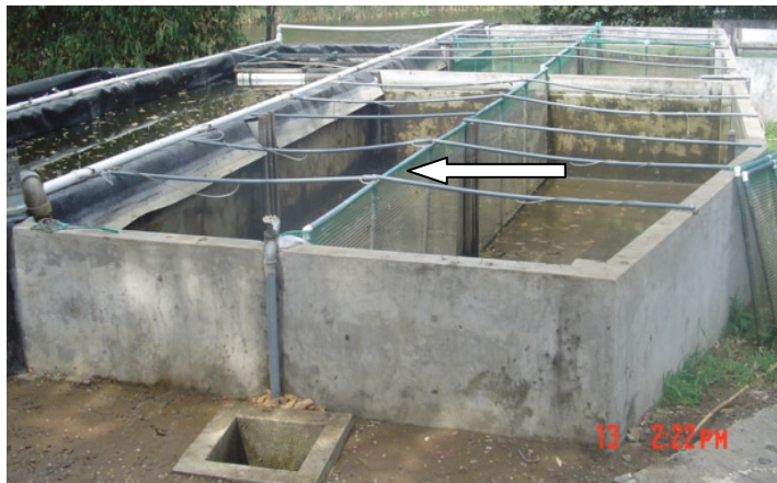
Figura 6. Estructura longitudinal construida en el interior de los tanques 1 y 2
