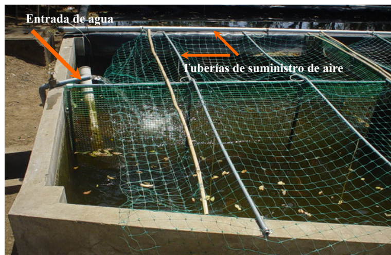
Figura 5. Tanque 1, en donde se observa las tuberías de suministro de agua y aire
