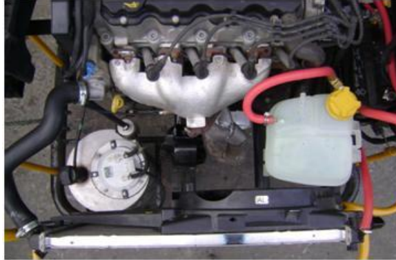
Figura 2.7 montaje del depósito de expansión
