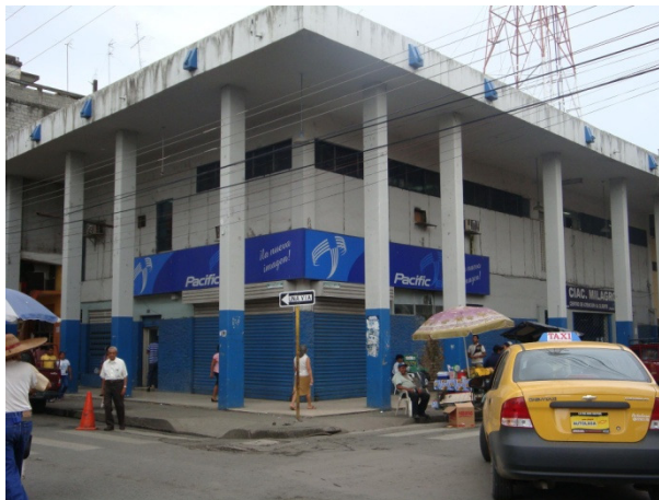
Foto 14: Edificio de la empresa telefónica
