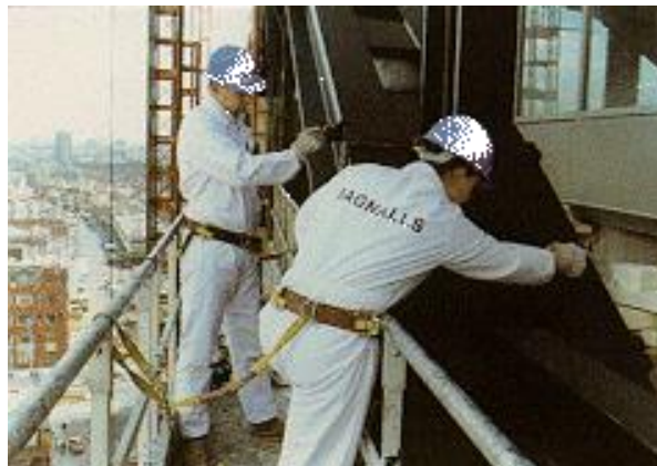
Figura # 2.29 "TRABAJO CON SEGURIDAD "
