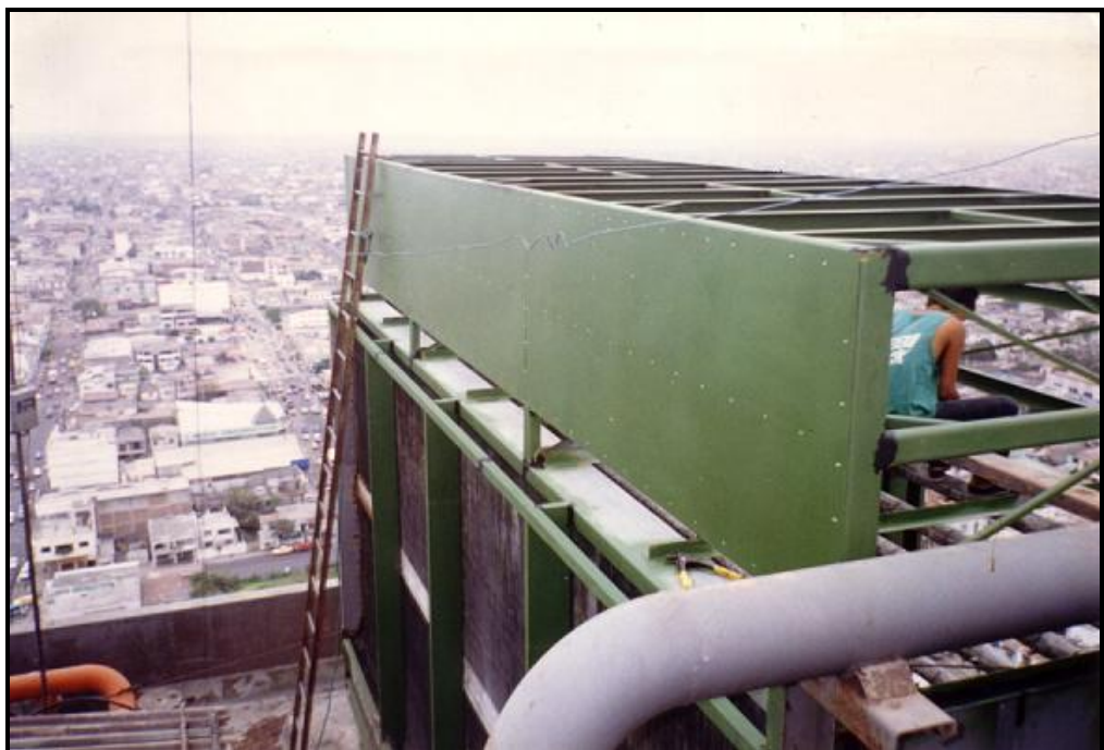
Figura 2.4. INSTALACIÓN ESTRUCTURA BASE PARA VENTILADORES
