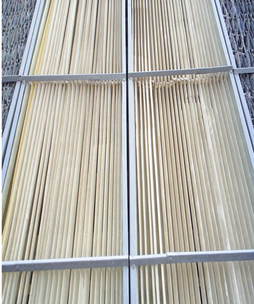
Figura 3.4 Los eliminadores de PVC en mal estado se reemplazaron por planchas de fibra de vidrio tipo zinc.
