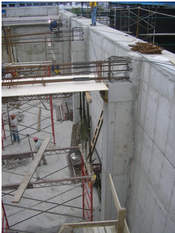
Construcción de Vigas en Tanque de Aireación
