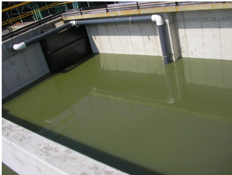
Vista de la Prueba de Estanqueidad.
