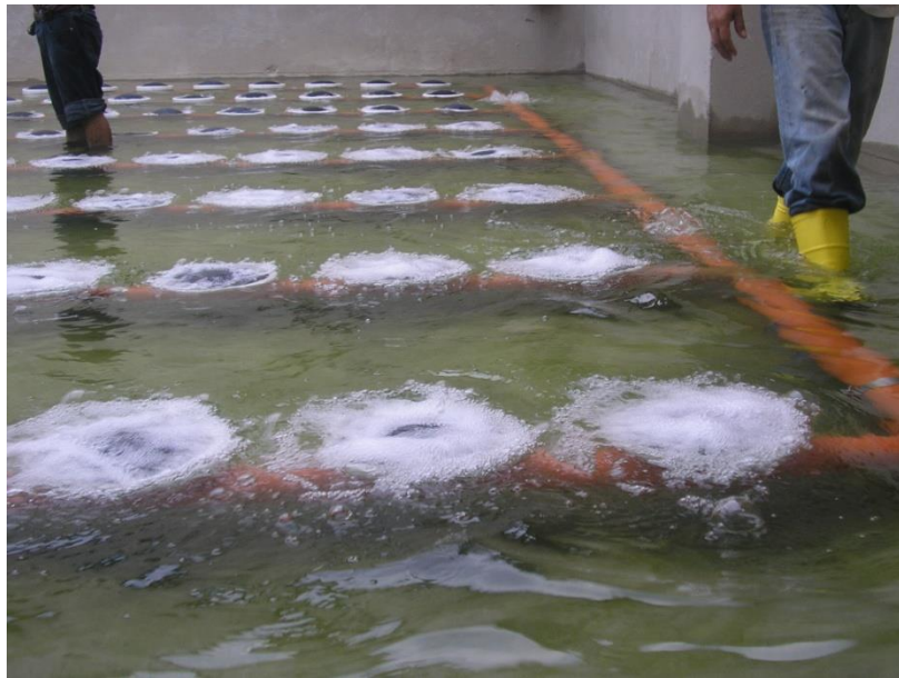
Prueba de Difusores en Tanque de Aireación
