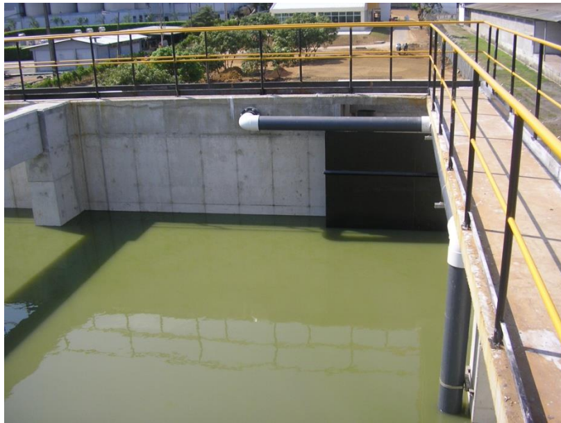
Prueba de Estanqueidad en el Tanque de Aireación
