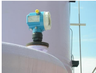
SENSOR DE NIVEL TANQUE HIPOCLORITO DE SODIO
