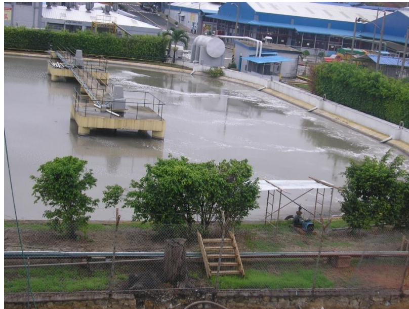
Laguna Anaerobia existente
