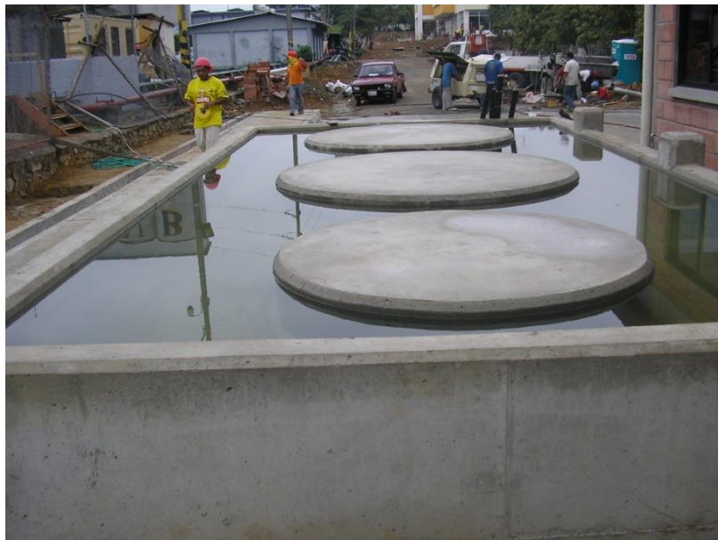
Caseta de Operaciones y Espesador de lodos de Acero
