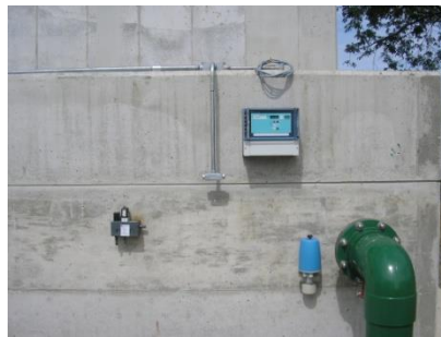
SENSOR DE NIVEL TANQUE HIPOCLORITO DE SODIO
