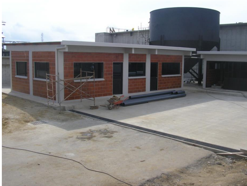
Caseta de Operaciones y Espesador de lodos de Acero
