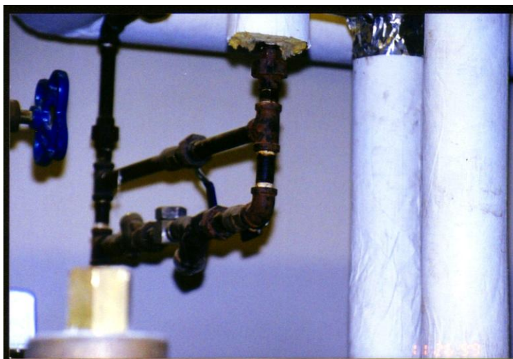
FIGURA 3.18. TRAMPA DE LINEA AL FINAL DE UNA TUBERÍA DE DISTRIBUCIÓN DE VAPOR
