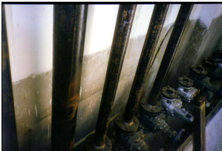
FIGURA 3.27. INICIOS DE INSTALACIÓN EN EL DISTRIBUIDOR DE VAPOR
