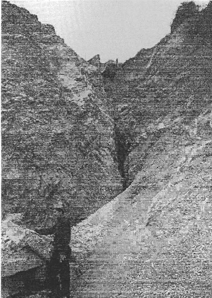
FIGURA 2.3 PUNTO DE DESCARGA DEL ALCANTARILLADO PLUVIAL DEL TERMINAL DE BARBASQUILLO SOBRE UNA FALLA GEOLÓGICA (EXTREMO OESTE)
