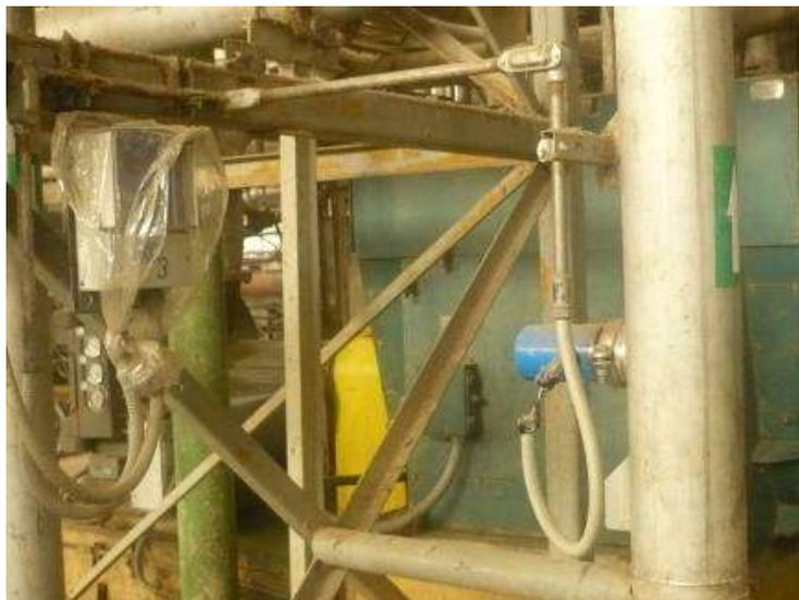
**FIGURA 2.20: MEDIDOR DE CONSISTENCIA INSTALADO EN LA LÍNEA DE ALIMENTACIÓN AL REFINADOR DE FIBRA CORTA.**
