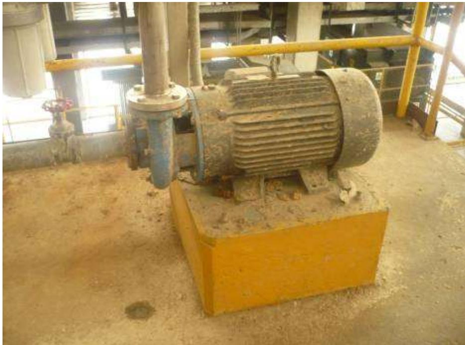
**FIGURA 2.15 BOMBA DE DUCHAS DEL ESPESADOR.**
