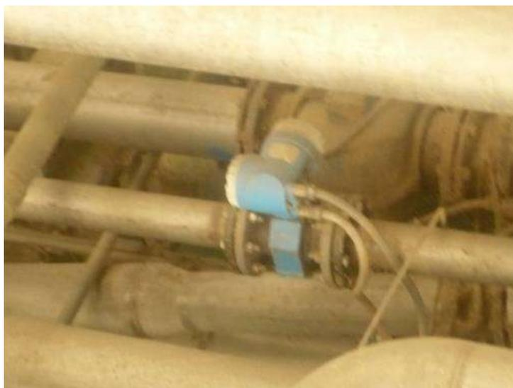
**FIGURA 2.22: MEDIDOR DE FLUJO DE ALIMENTACIÓN DE FIBRA
