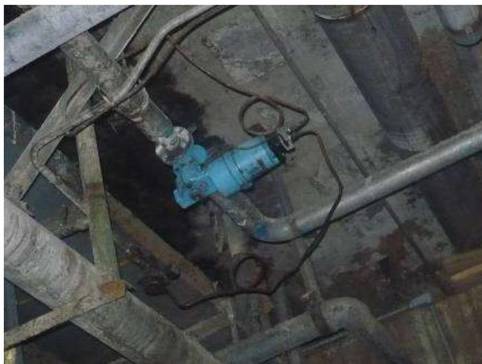
**FIGURA 2.21 VÁLVULA PARA REGULACIÓN DE CONSISTENCIA
