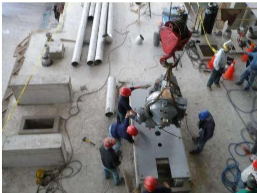
**FIGURA 2.6 MONTAJE DE REFINADOR 20" DD**
