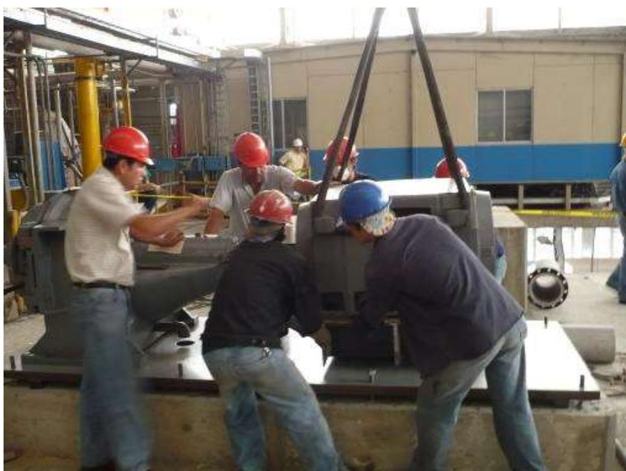
**FIGURA 2.7 MONTAJE DEL MOTOR.**
