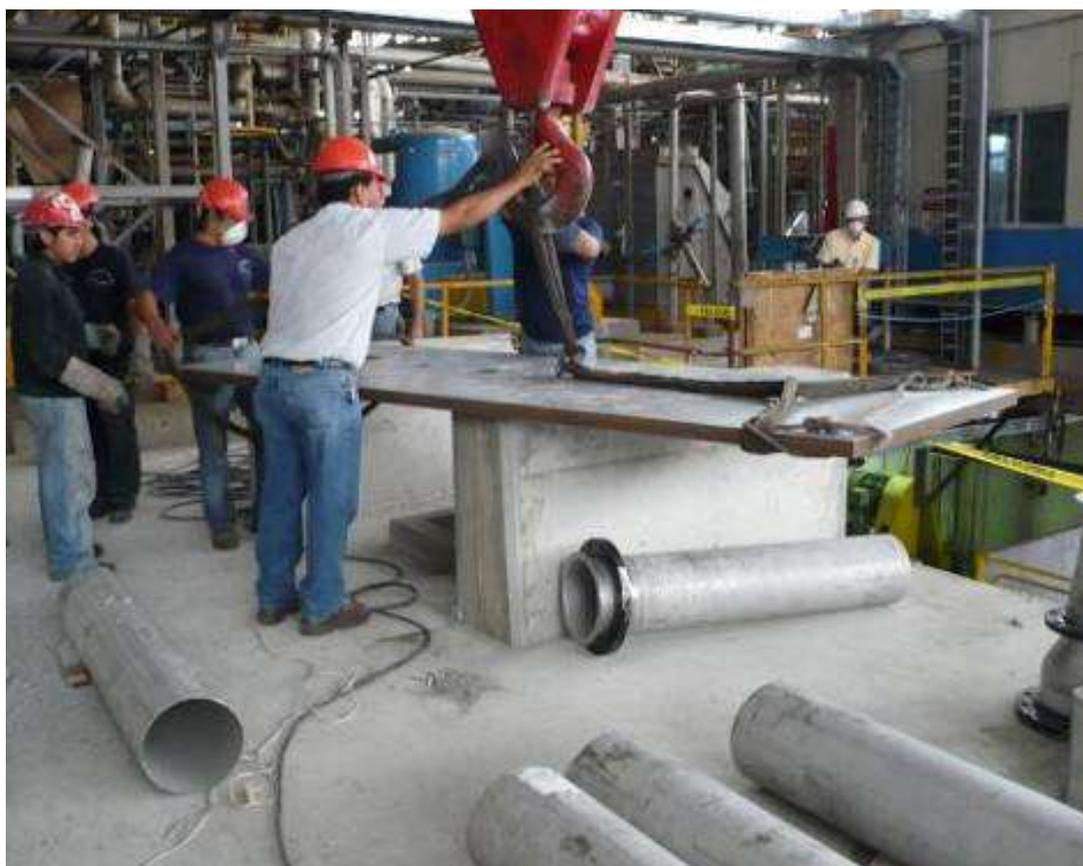
**FIGURA 2.5 INSTALACIÓN DE PLACAS BASE**
