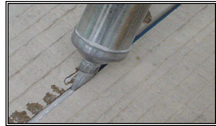
Figura 13. Sellado de juntas.
