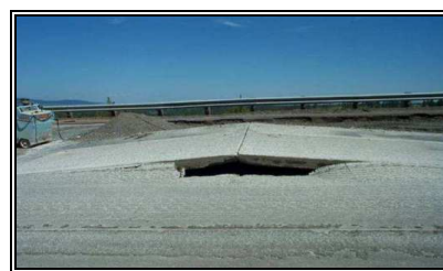
Figura 19. Levantamiento de losa.
