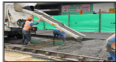
Figura 5. Colocación del hormigón.
