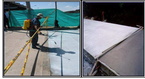
Figura 9. Curado del hormigón con compuesto químico.
