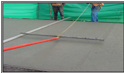
Figura 8. Macrotexturizado del hormigón.
