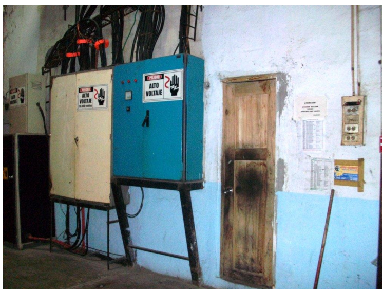
FIGURA 3.12. GENERADORES ELÉCTRICOS Y BAÑO DE VARONES
