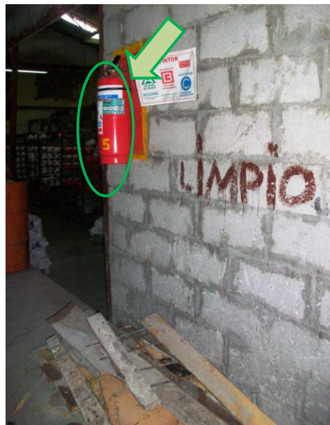
FIGURA 3.19. EXTINTOR S5 DEL ÁREA DE TEXTIL CHINO
