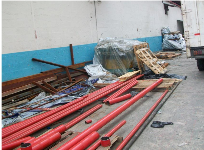
FIGURA 3.15. TUBERÍAS DE RED DE AGUA PARA SER INSTALADAS
