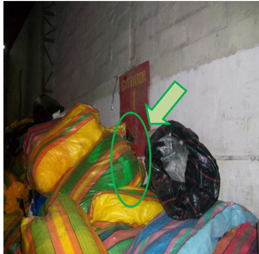
FIGURA 3.18. EXTINTOR S11 DEL ÁREA DE EXTRUSIÓN DE SACOS
