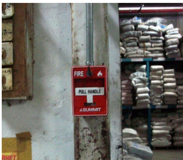
FIGURA 3.13. ESTACIÓN MANUAL PARA ACTIVACIÓN DE ALARMA CONTRA INCENDIO
