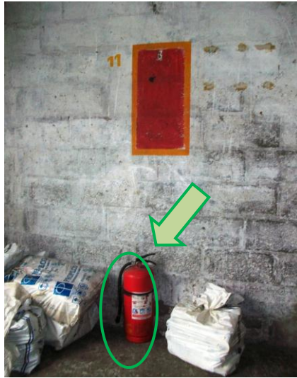
FIGURA 3.20. EXTINTOR S12 DEL ÁREA DE EXTRUSIÓN DE SACOS
