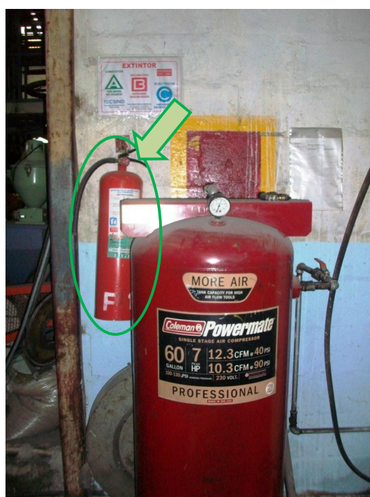
FIGURA 3.17. EXTINTOR F1 DEL ÁREA DE SELLADO
