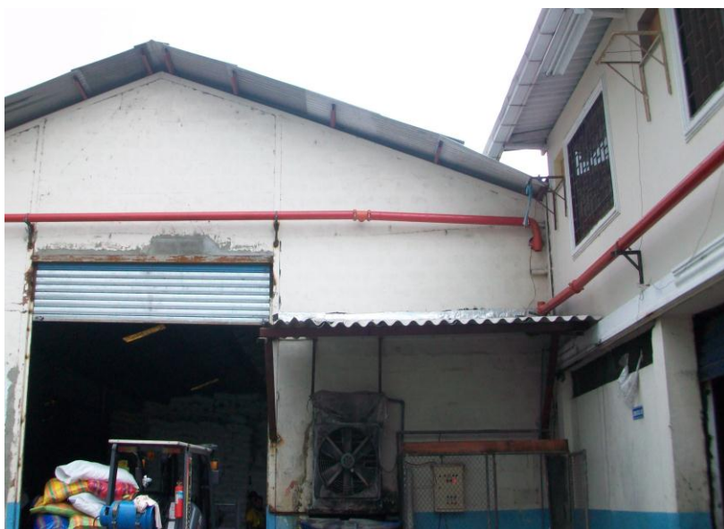
FIGURA 3.14. RED DE AGUA EN EXTERIORES DE BODEGA
