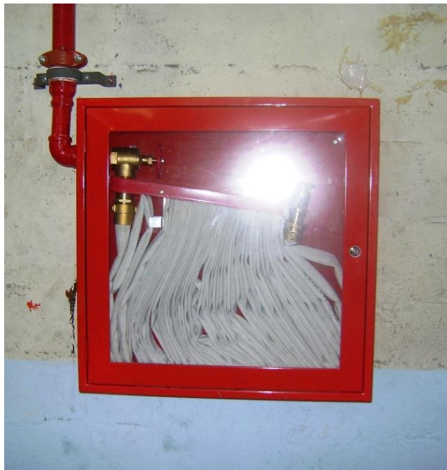
FIGURA 3.16. ARMARIO DE EMERGENCIA Y BOCA DE INCENDIO EN ÁREA DE IMPRESIÓN
