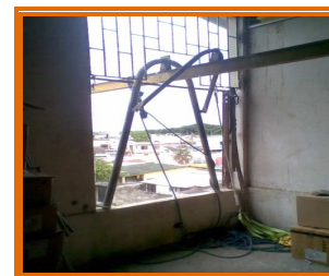
FIGURA 2. Ventana de izaje de materiales.
