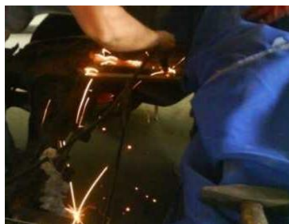
FIG-4.10 INSTALACIÓN DE BASE MOTOR Y COMPRESOR
