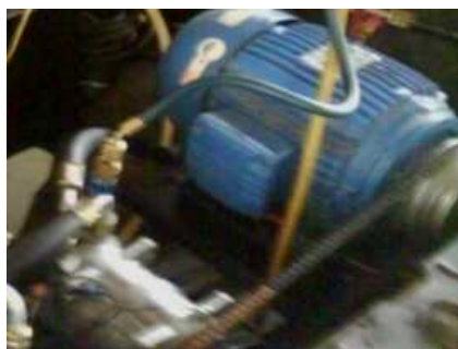
FIG-4.15 COLOCACIÓN DE BANDA
