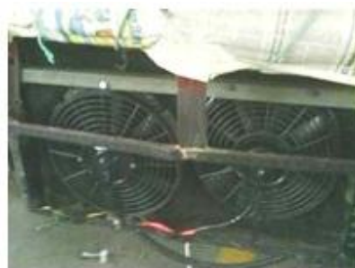
FIG-4.16 INSTALACIÓN DE LOS ELECTROVENTILADORES
