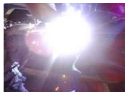
FIG-4.11 SOLDADO DE BASE MOTOR Y COMPRESOR
