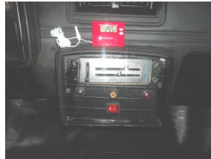
FIG-2.30 TABLERO DE CONTROL DEL SISTEMA A/C RECONSTRUIDO
