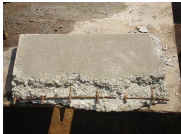
Figura 2. Vista interior de un panel de hormigón
