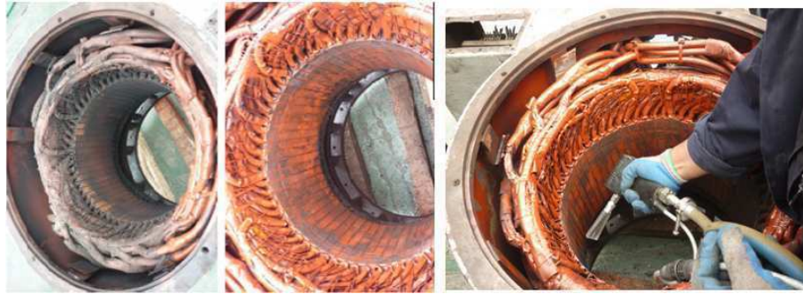
Figura 1.8 APLICACIÓN DE ICEBLASTING A UN MOTOR ELÉCTRICO.
