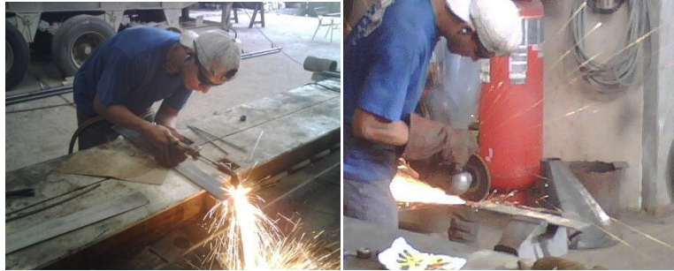
FIG. 2.17 PROCESO DE CONSTRUCCIÓN DE PLATINA DE SOPORTE
