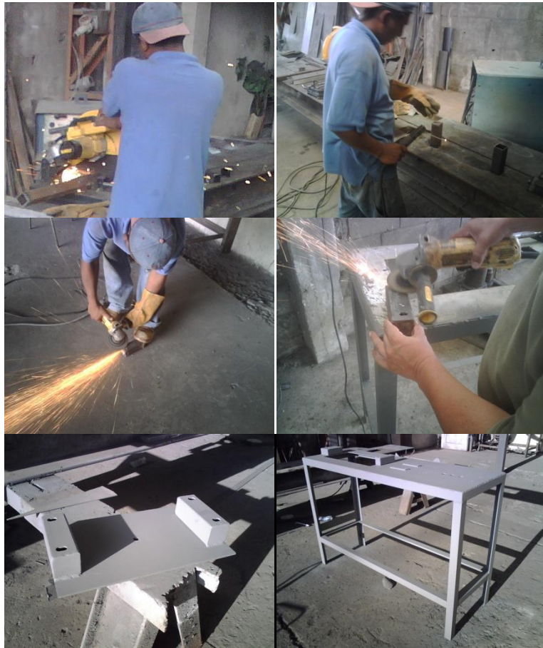
FIG. 2.12 PROCESO DE CONSTRUCCIÓN DE LOS SOPORTES DE RODAMIENTOS
