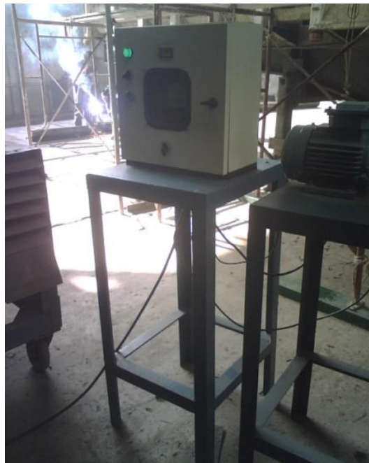
FIG. 2.20 FOTOGRAFÍA DE LA ESTRUCTURA DE SOPORTE TERMINADA
