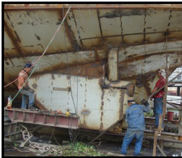
Figura N° 16. Montaje de codaste de Babor.
