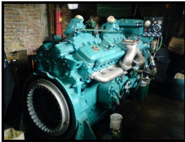
Figura N° 33. Nuevo motor principal instalado.
