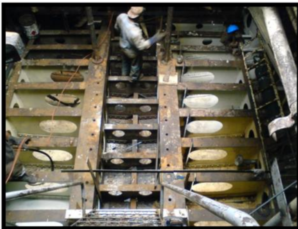
Figura N°13. Corte de estructurales para montaje de bases para motores principales.
