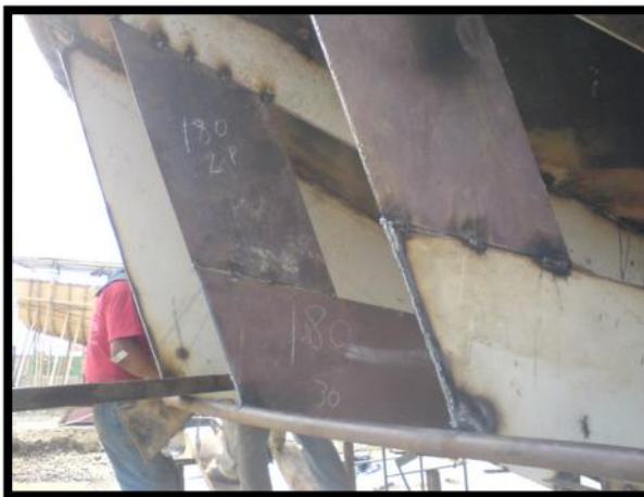
Figura N° 5. Armado de longitudinales de fondo.
