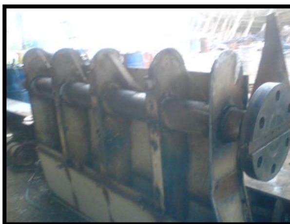
Figura N°12. Construcción de palas del timón.
