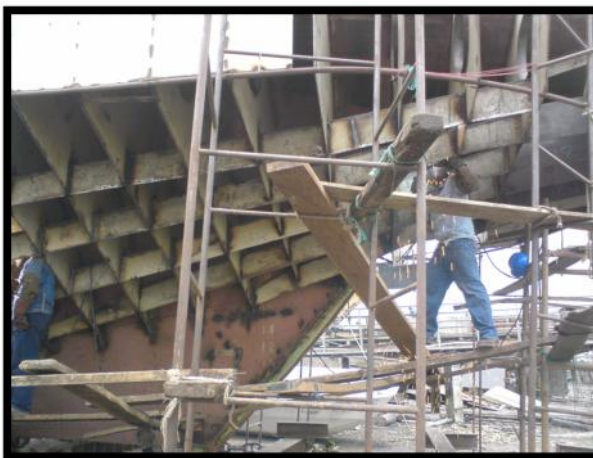
Figura N° 6. Soldadura del ala de longitudinales de fondo.
