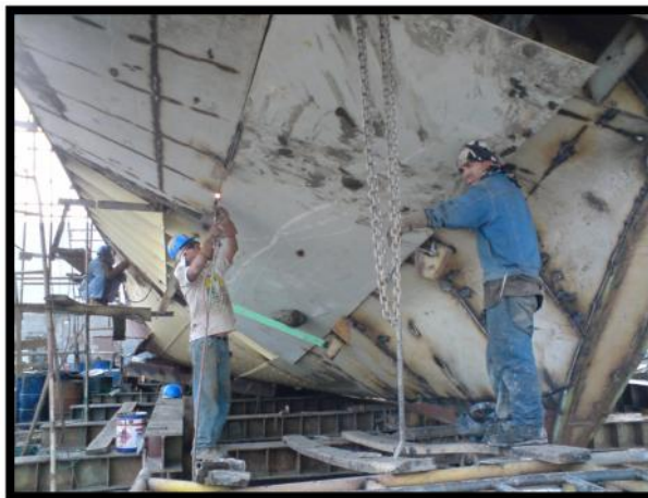
Figura N° 8. Montaje del fondo del casco.
