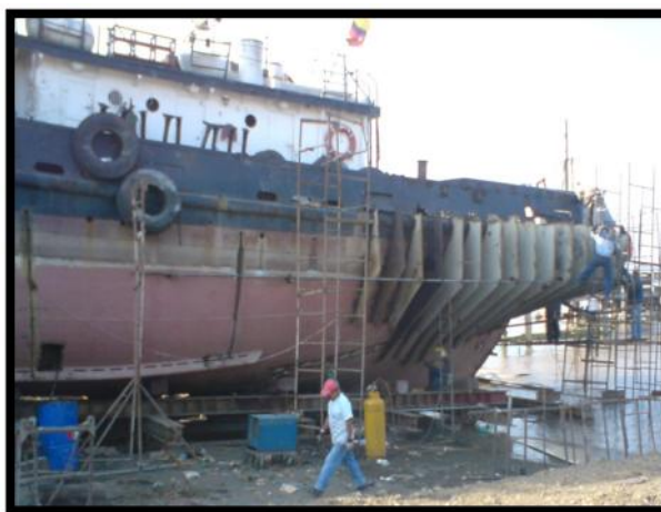
Figura N° 4. Montaje de nuevas cuadernas y mamparos.
