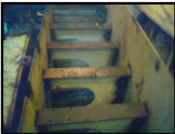
Figura N°14. Montaje de bases de motores principales.
