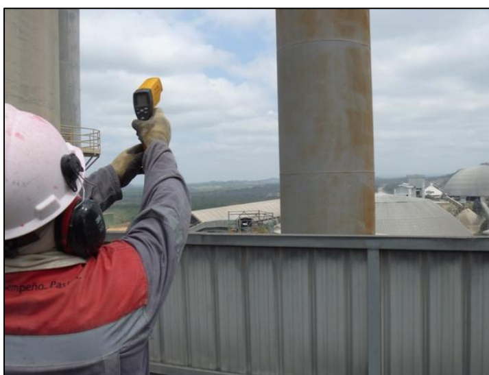
FIGURA 2.6. MEDICIÓN DE TEMPERATURA EN LA CHIMENEA
