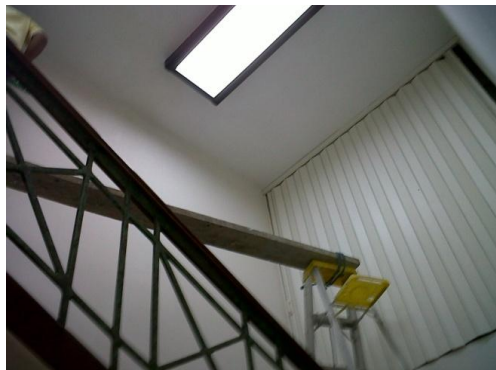
Fig.1. 3 Condiciones inseguras de trabajos eléctricos
